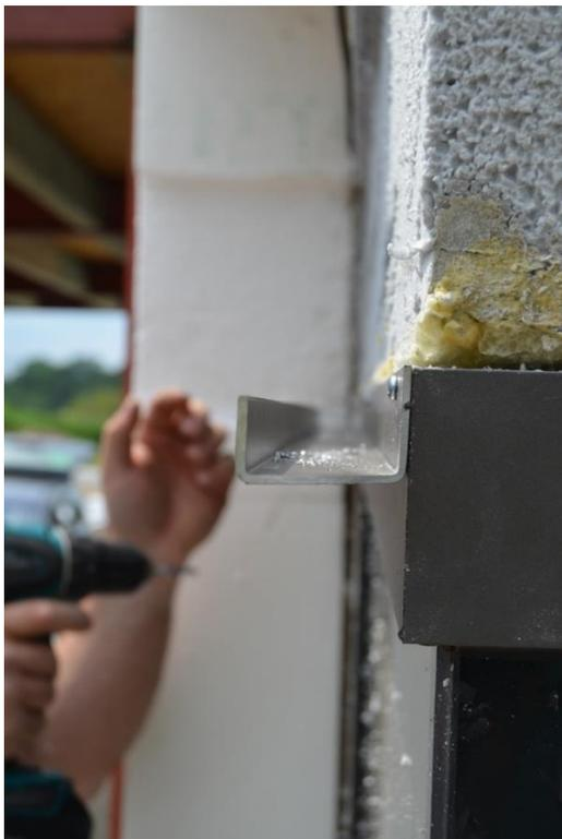
3. Wir setzen den Purenit-Kasten auf die Gründungsleiste auf und mithilfe der Libelle gleichen wir ihn so aus, dass er sich in vertikaler Ebene befindet.
